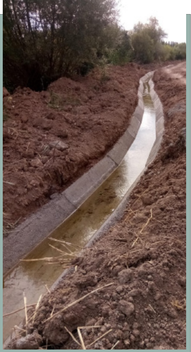
Sulama Kanalı Çalışmaları
