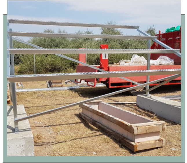
Çatalelma Köyü G.E.S. Çalışmaları
