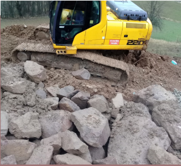
Yol Onarım Çalışmaları
