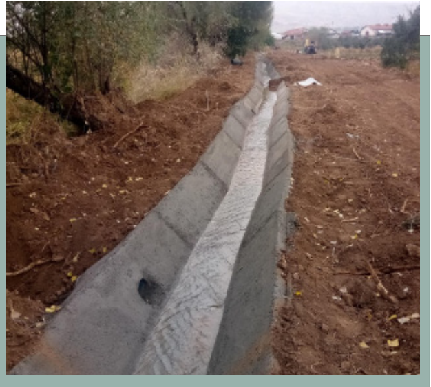
Sulama Kanalı Çalışmaları
