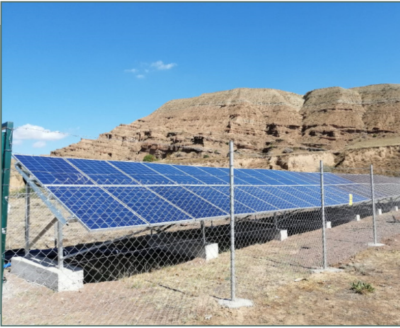
Merkez Satıyüzü Köyü Güneş Enerji Sistemi Yapımı
