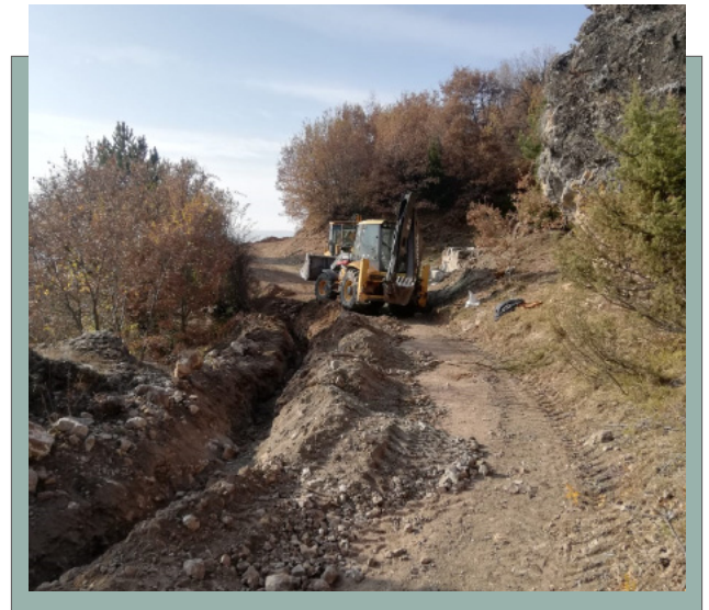
Erenler Köyü İçmesuyu Çalışmaları
