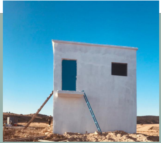
İkiçam Köyü İçmesuyu Deposu
