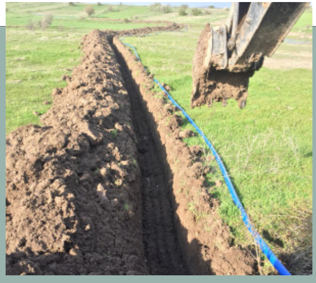
Kayıçivi İçmesuyu Çalışmaları
