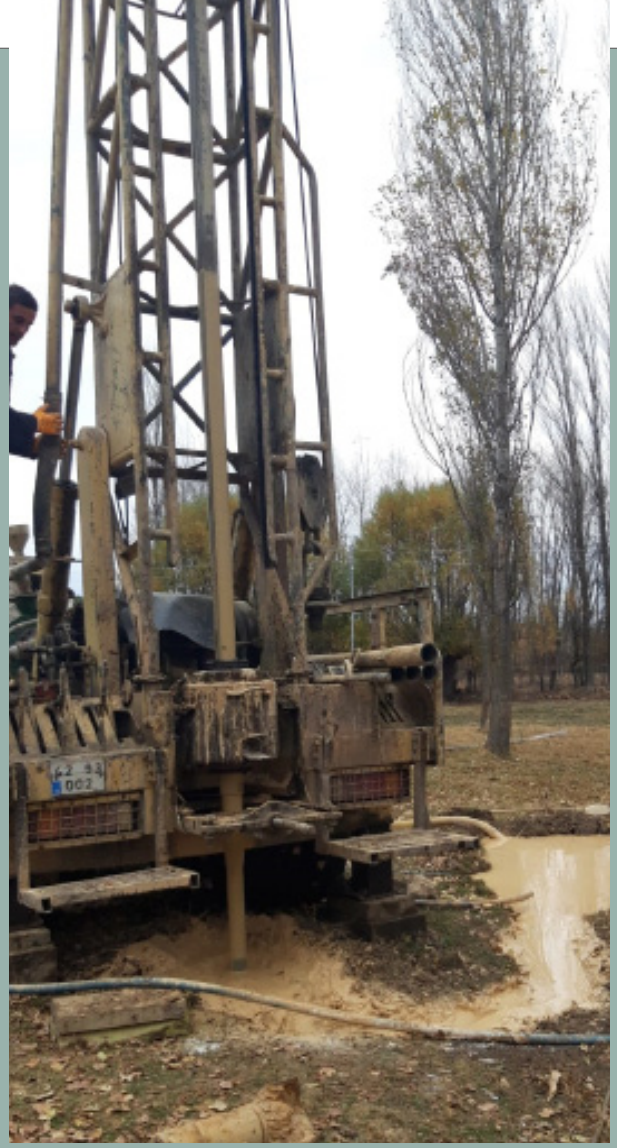
Başovacık Köyü Sondaj Çalışmaları
