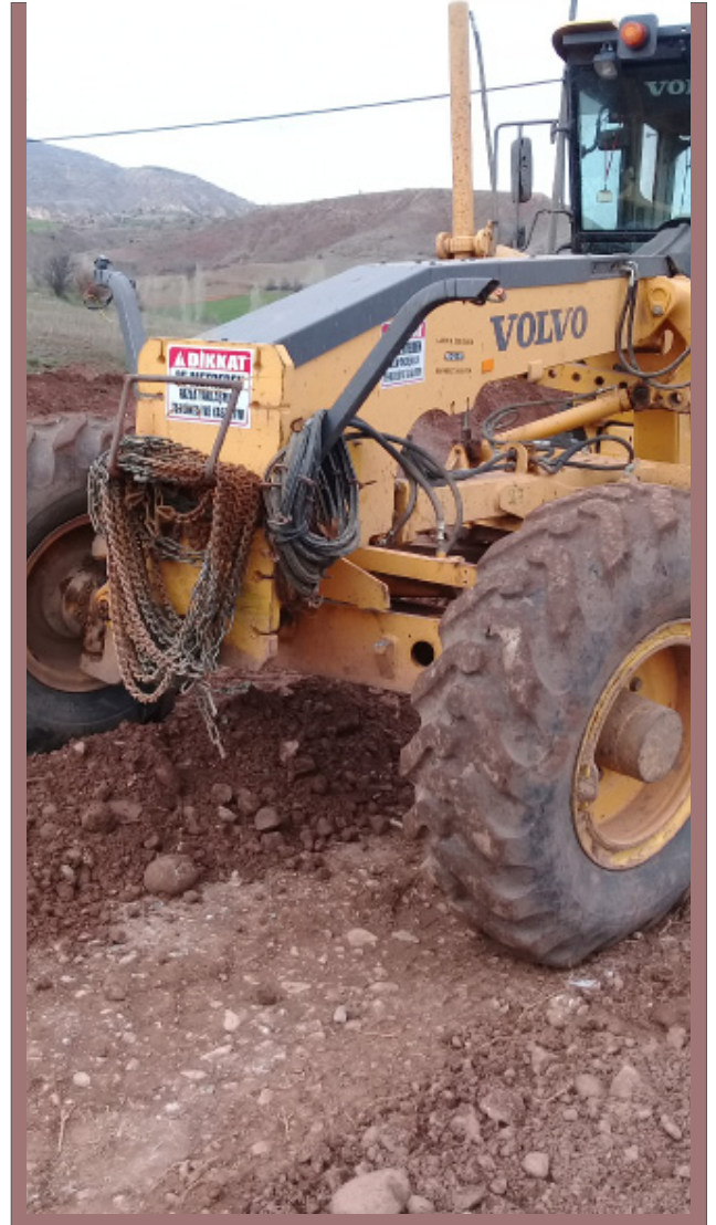
Greyderli Bakım Çalışmaları
