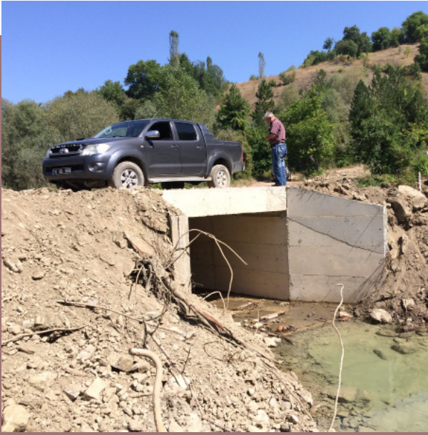
Sanat Yapısı Çalışmaları
