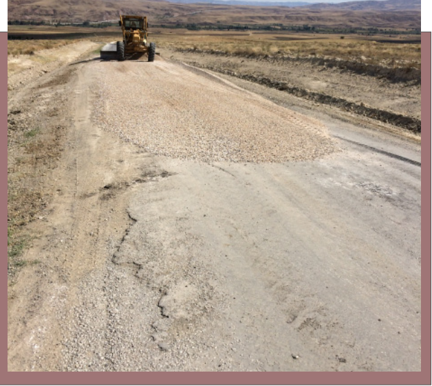
Malzemeli Bakım Çalışmaları
