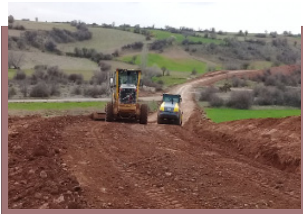
Greyderli Bakım Çalışmaları
