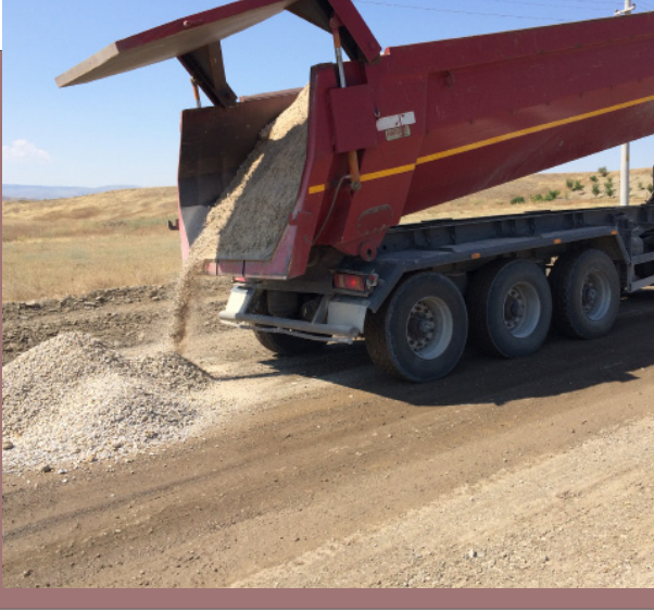
Malzemeli Bakım Çalışmaları
