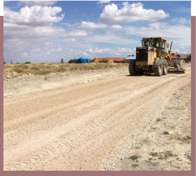
Malzemeli Bakım Çalışmaları
