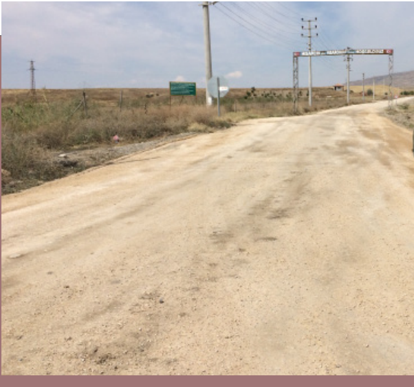
Malzemeli Bakım Çalışmaları
