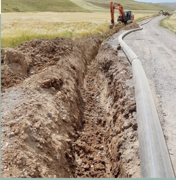
Saraycık İçmesuyu Grubu Çalışmaları
