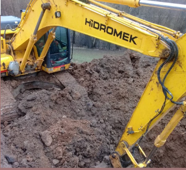
Yol Onarım Çalışmaları
