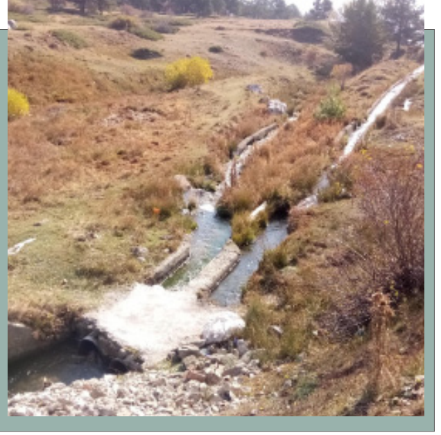
Sulama Kanalı Çalışmaları
