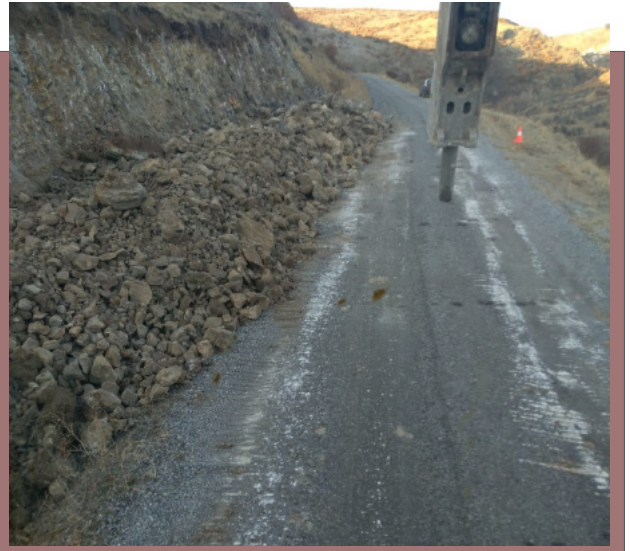
Yol Onarım Çalışmaları
