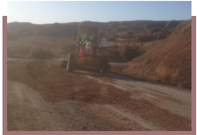
Asfalt Altı Hazırlık Çalışmaları
