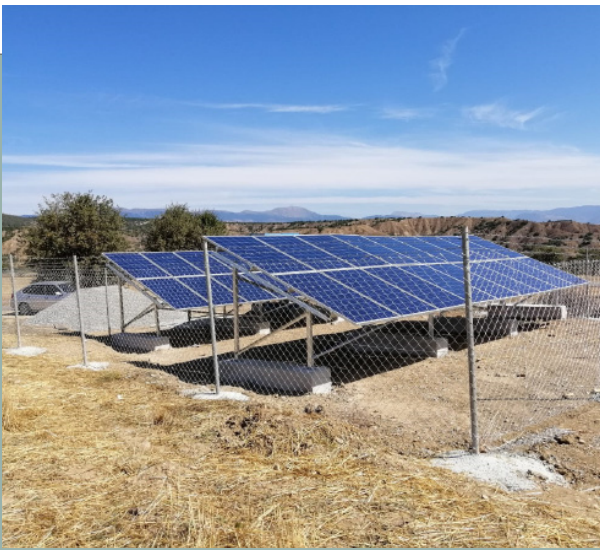
Kavaklı Köyü Güneş Enerji Sistemi
