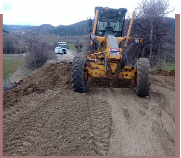
Yol Onarım Çalışmaları
