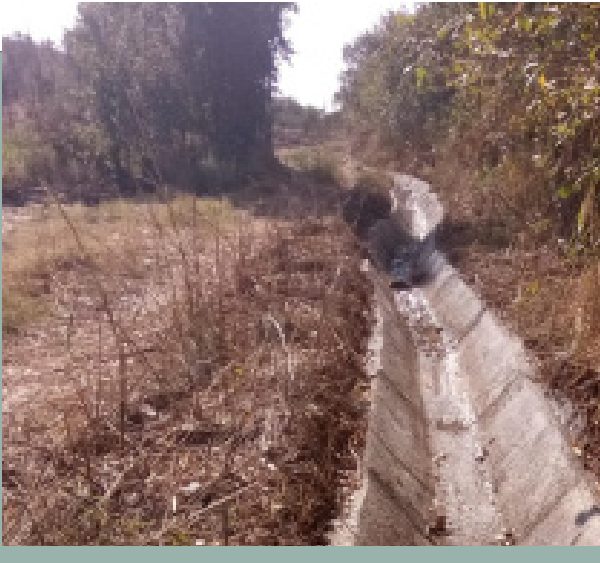
Sulama Kanalı Çalışmaları
