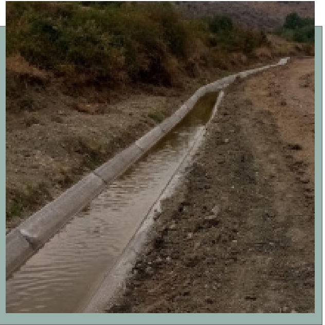
İçyenice Köyü Sulama Kanalı
