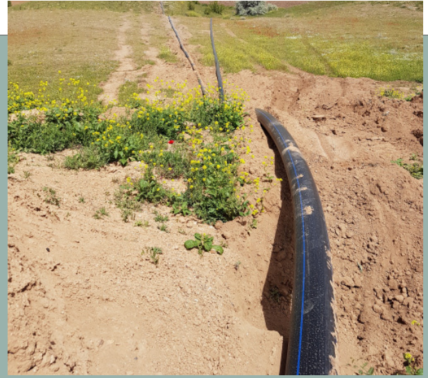
Saraycık İçmesuyu Grubu Çalışmaları
