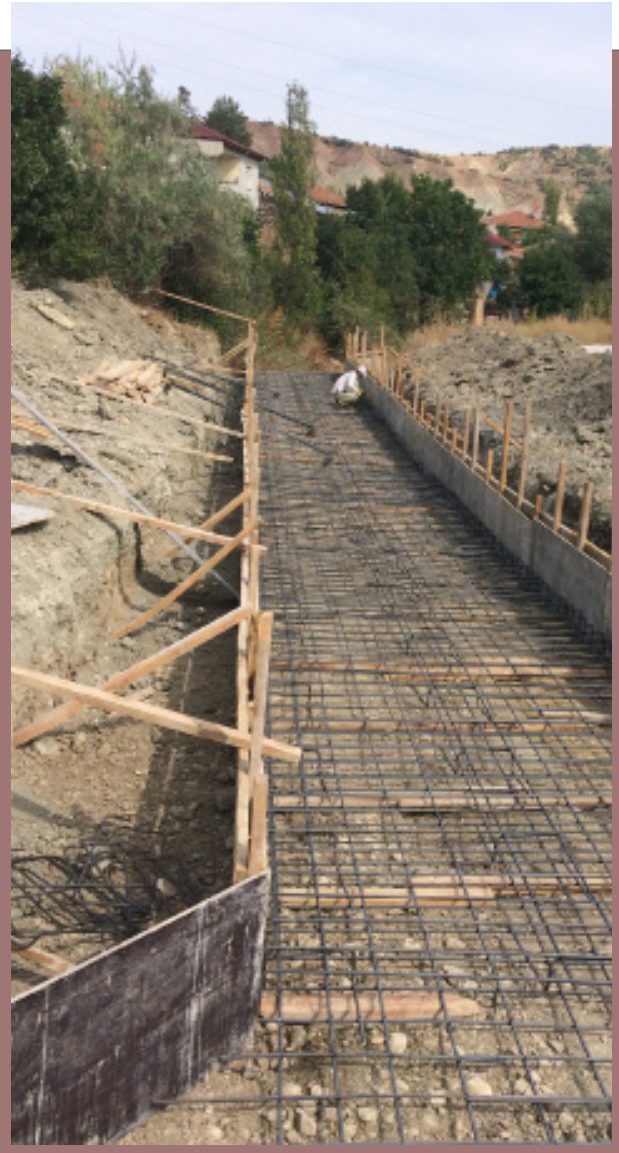
Sanat Yapısı Çalışmaları
