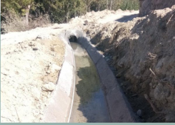
Sulama Kanalı Çalışmaları
