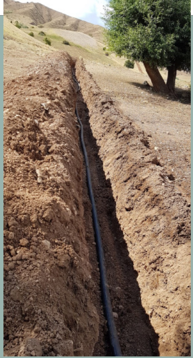
Dutağaç Köyü İçmesuyu Çalışmaları
