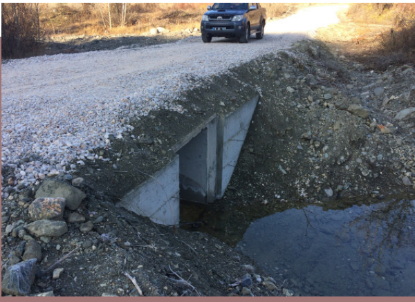
Sanat Yapısı Çalışmaları
