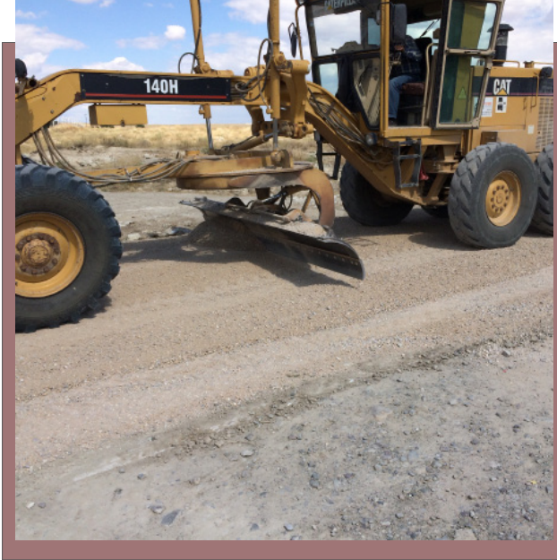
Greyderli Bakım Çalışmaları
