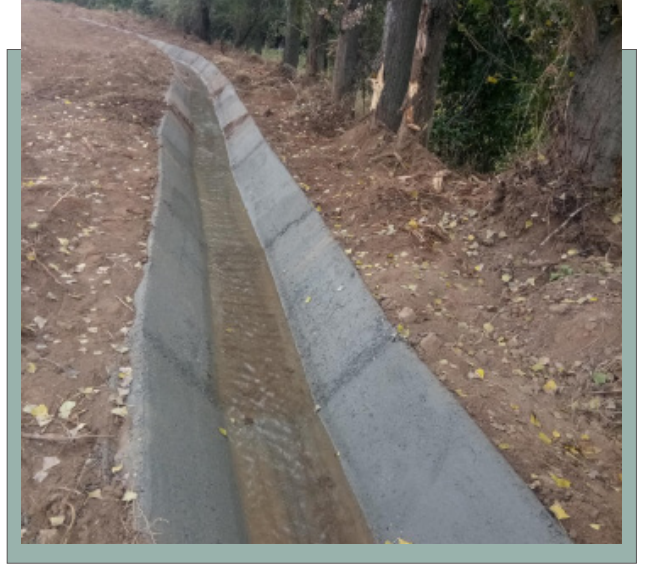
Sulama Kanalı Çalışmaları
